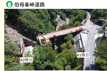
2号橋A2橋台工事施工中 (R3.8)
